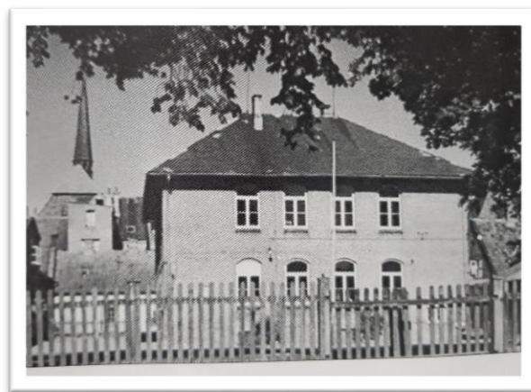
Abb. 5: Ehem. Mädchenschule von der Reeperbahn aus gesehen
