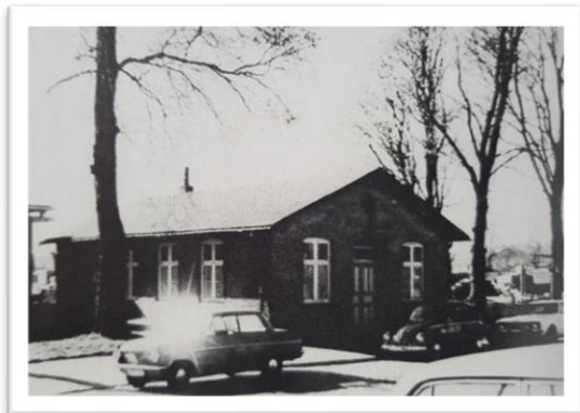
Abb.1: Abgerissenes Gebäude vor Pumpstation auf vor gegenüberliegender Straßenseite
